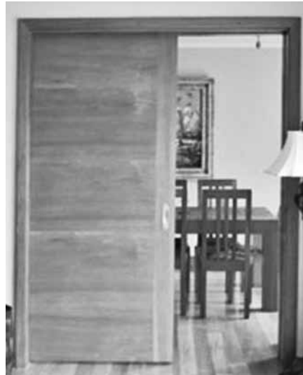
Permite montar y desmontar riel y carros sin destruir el muro o nicho.
